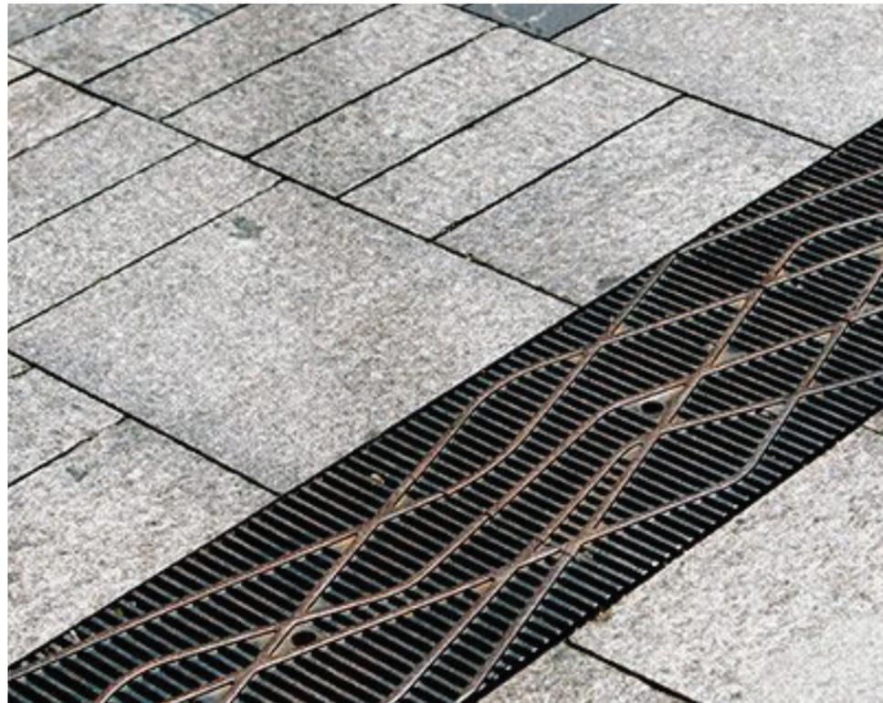
TRENCH DRAIN CAST IRON GRATE
