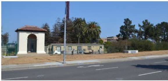
① METER HOUSE AND EL CAMINO FRONTAGE
