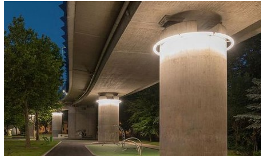
ILUMINACIÓN DE COLUMNAS
