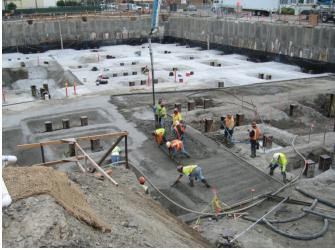
Mud-slab pour and finish at Basement level
